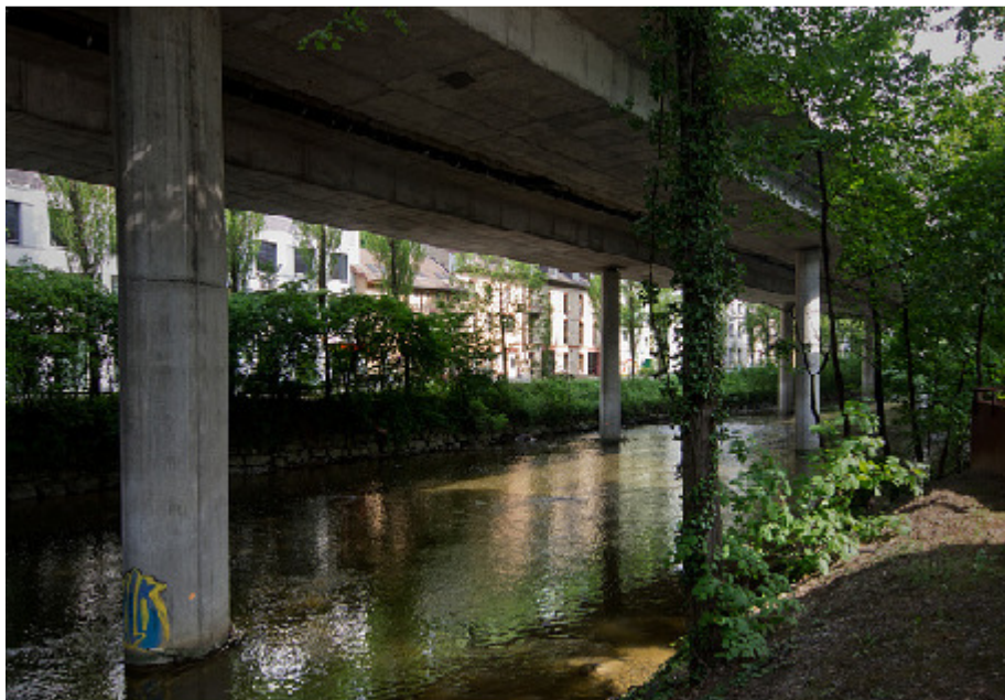
In die Sihl gestellte Autobahn (Stadt Zürich)
